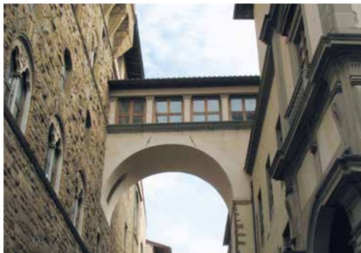
Il corridoio sospeso di via della Ninna e, in basso, il tratto del Corridoio Vasariano sopra a Ponte Vecchio.
